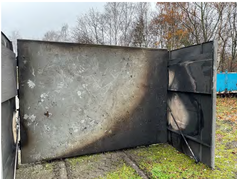
Figur 25. Ovansidan balkongplatta efter försöket.
