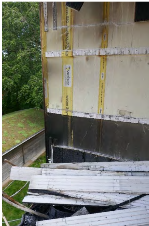
Figur 14. Läkt och fasadskiva bakom fasadpanelen.
