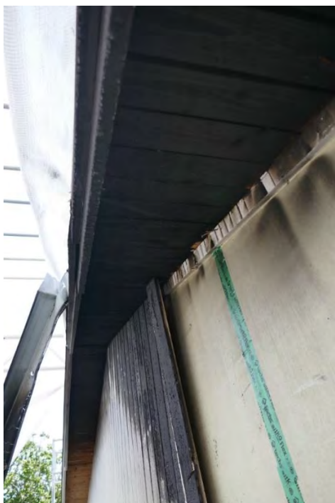
Figur 15. Ytterväggen ansluter mot råsponen rakt ovanför balkongerna.
