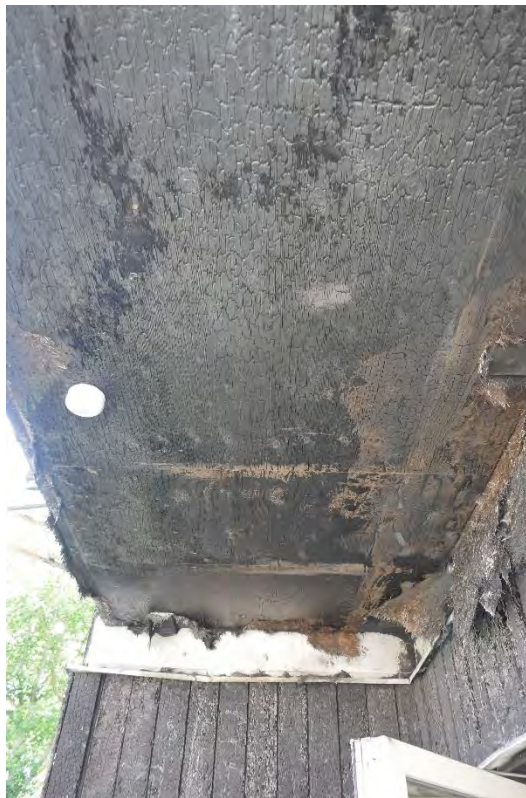
Figur 18. Brandskadat trä på undersidan balkongplatta. Fotot taget på plan 2. Brandvarnaren är monterad efter branden.
